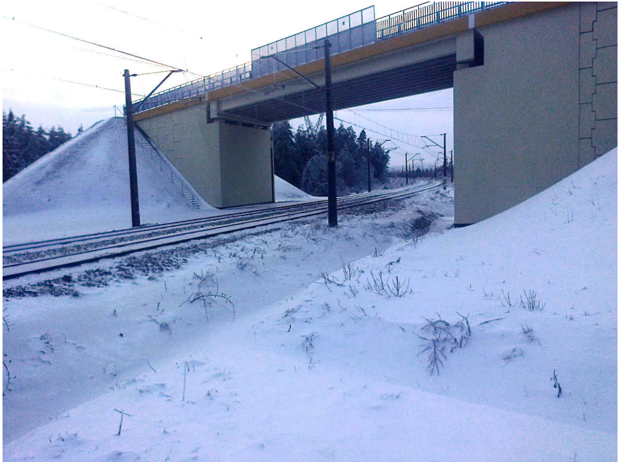
Fot. 1. Wiadukt nad linią kolejową nr 8 w miejscowości Występa Kolejowa – jedyny obiekt minimalizujący (w ograniczonym stopniu) barierowe oddziaływanie drogi S-7 na łączność ekologiczną
