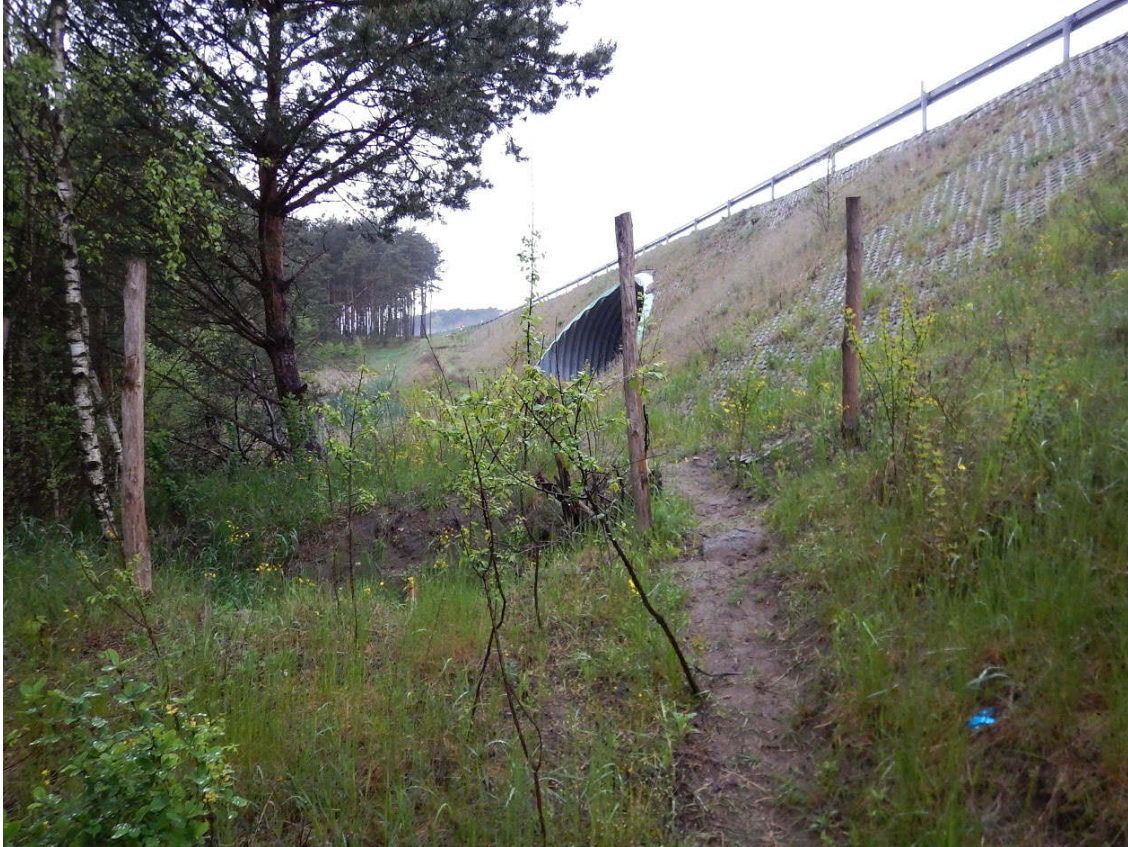
Fot. 11. Dolne przejście dla średnich zwierząt k. miejscowości Zielonka-ścieżki w otoczeniu świadczą o intensywnym wykorzystaniu obiektu przez ludzi
