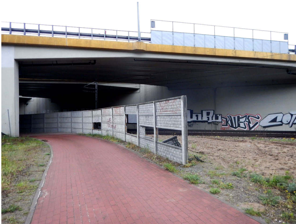
Fot. 16. Wiadukt nad linią kolejową C-E65 w miejscowości Stryszek- lokalizacja ścieżki rowerowej i chodnika na powierzchni powoduje brak wykorzystania przez duże ssaki
