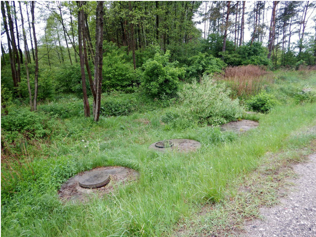
Fot. 32. Pułapki dla płazów (studnie i separatory) zaprojektowane zostały nawet w obszarach siedliskowych płazów-np. na skraju podmokłych olsów
