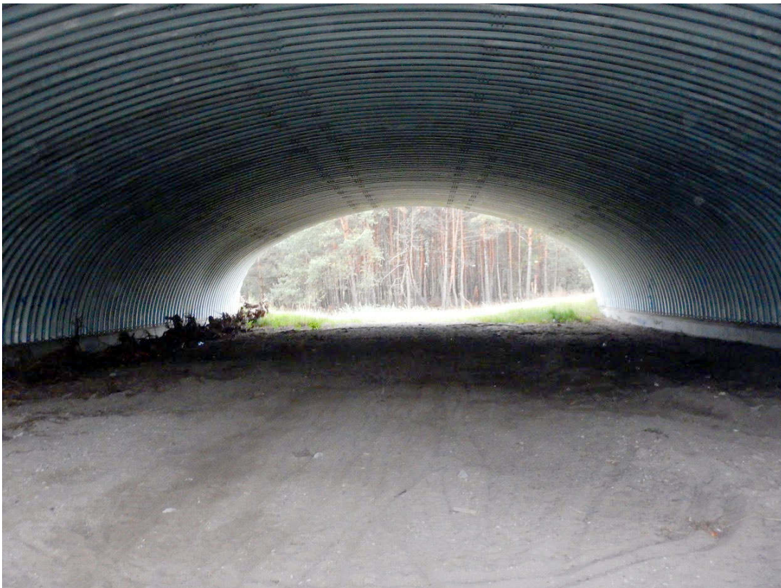
Fot. 6. Dolne przejście dla średnich zwierząt k. miejscowości Zielonka-ubogie zagospodarowanie powierzchni znacząco ogranicza funkcjonalność
