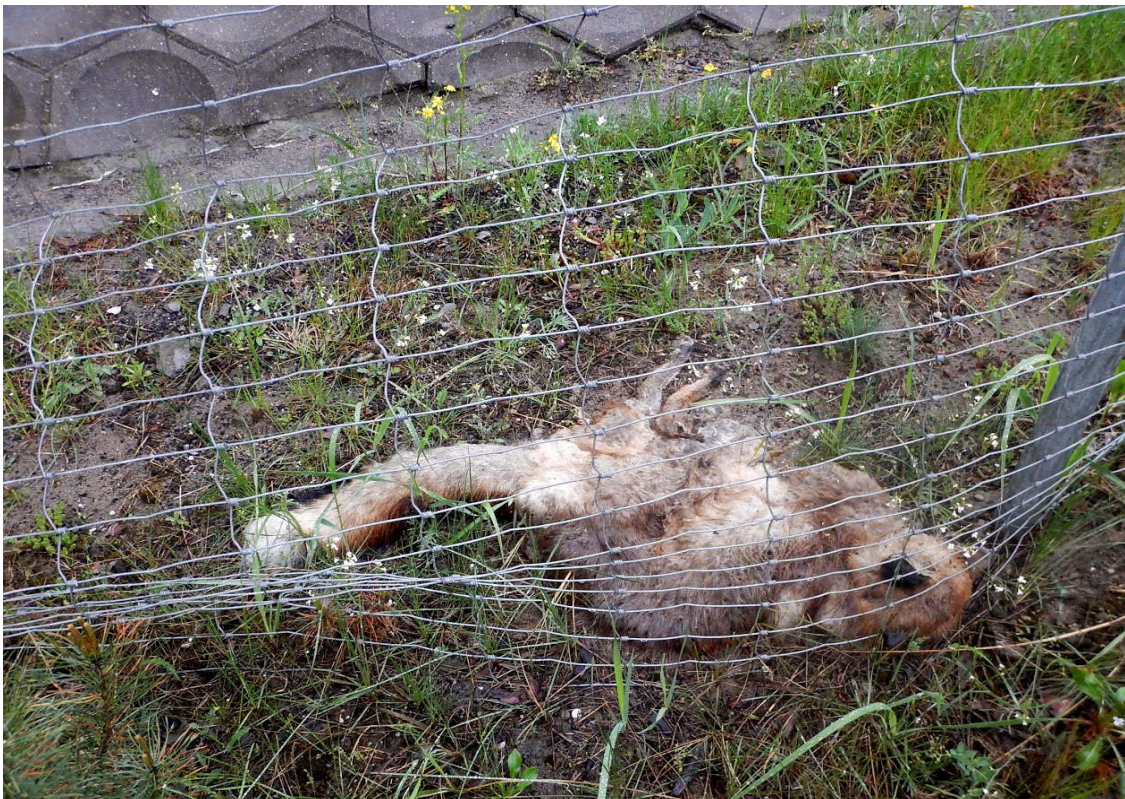
Fot. 18. Wiadukt nad linią kolejową C-E65 w miejscowości Stryzek-ogrodzenia ochronne posiadają liczne nieszczelności-martwy lis po wewnętrznej stronie płotu
