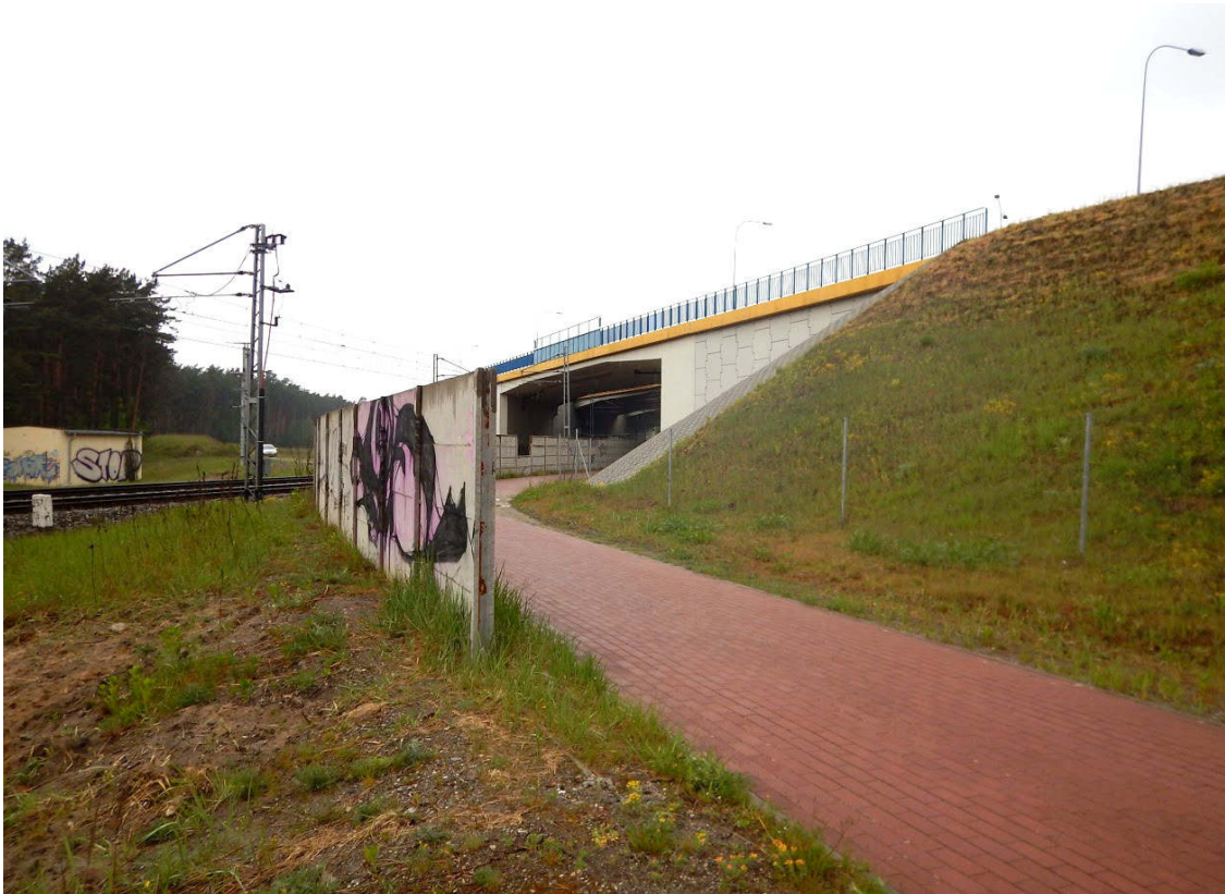
Fot. 17. Wiadukt nad linią kolejową C-E65 w miejscowości Stryzek-lokalizacja ścieżki rowerowej i chodnika na powierzchni powoduje brak wykorzystania przez duże ssaki
