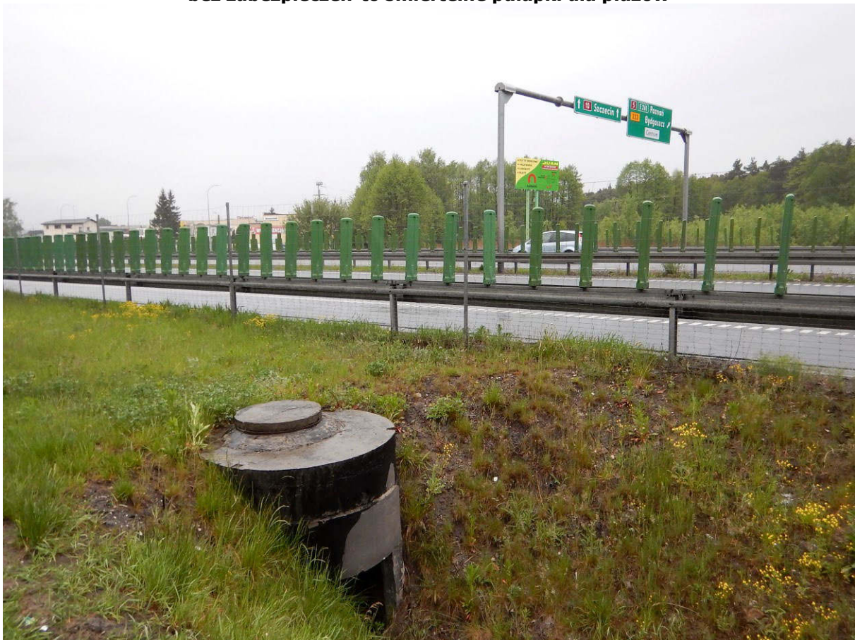
Fot. 30. Na analizowanym odcinku drogi S-5/S-10 znajdują się liczne studnie wpadowe bez zabezpieczeń-to śmiertelne pułapki dla płazów
