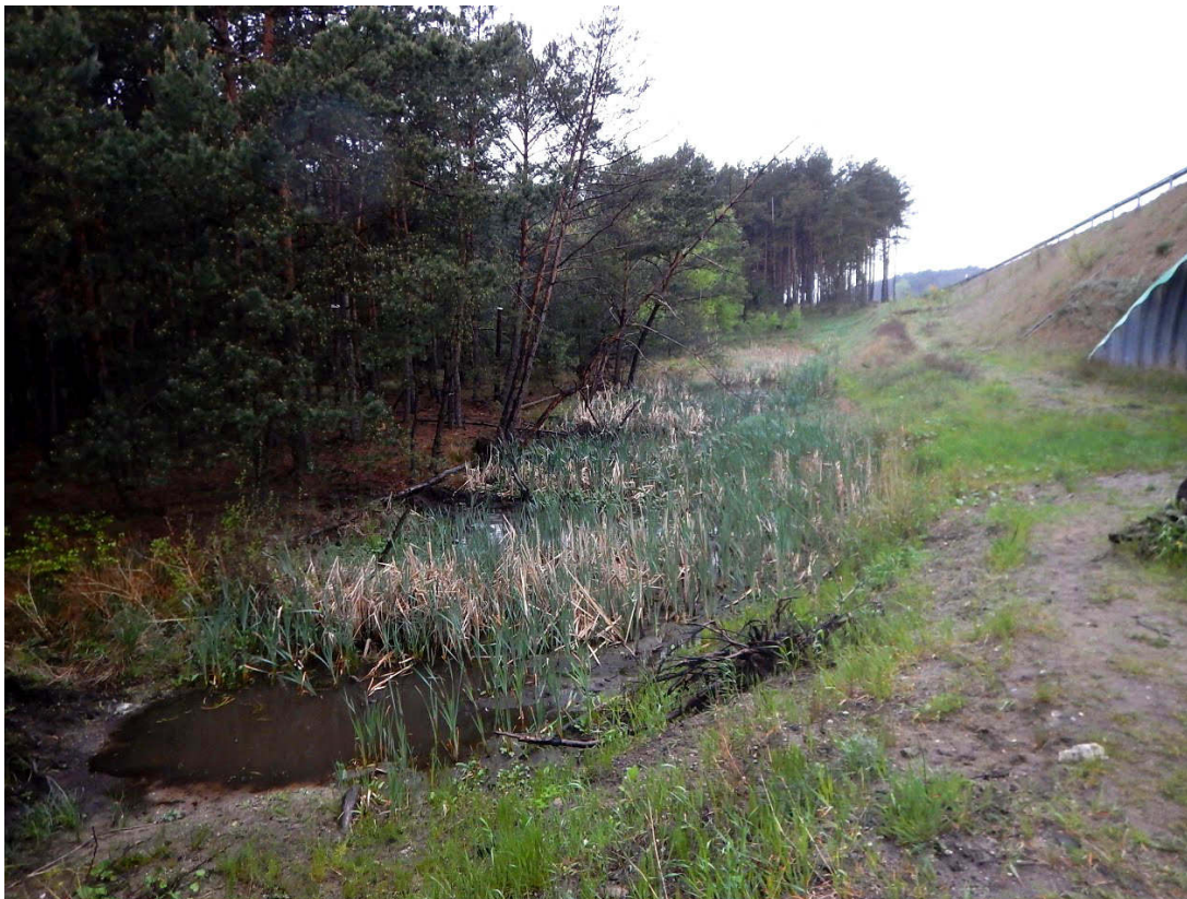
Fot. 4. Dolne przejście dla średnich zwierząt k. miejscowości Zielonka – w miejscu budowy przejścia zniszczona fragment cennego siedliska herpetofauny
