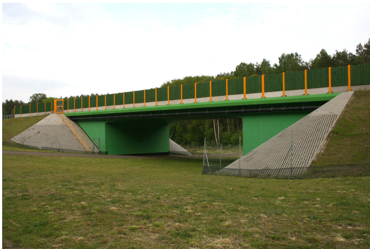
Fot. 1. Przejście dolne dla dużych zwierząt k. miejscowości Chełmsko posiada wymiary odpowiednie dla wszystkich gatunków zwierząt. Jaskrawa kolorystyka może odstraszać niektóre gatunki i osobniki.
