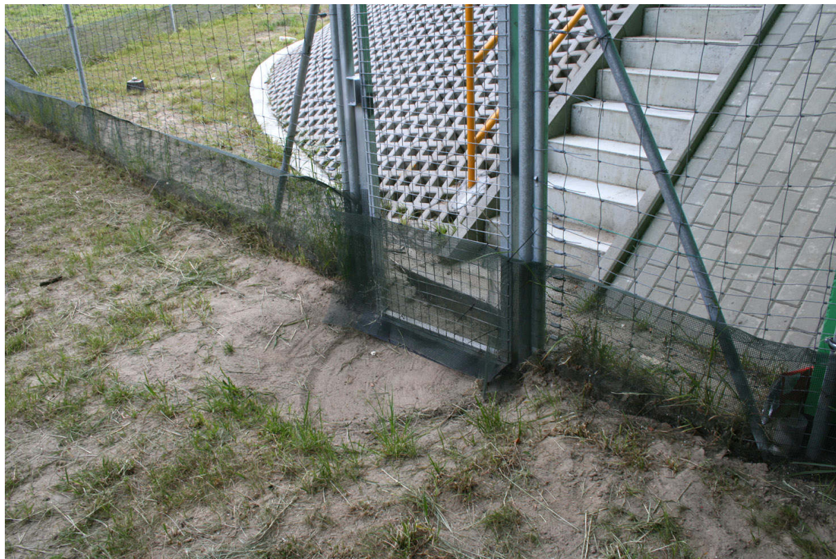
Fot. 4. Ogradzenia dla małych zwierząt z siatek polimerowych posiadają ograniczoną skuteczność, ich szczelność jest ograniczona w obrębie bram i furtek.
