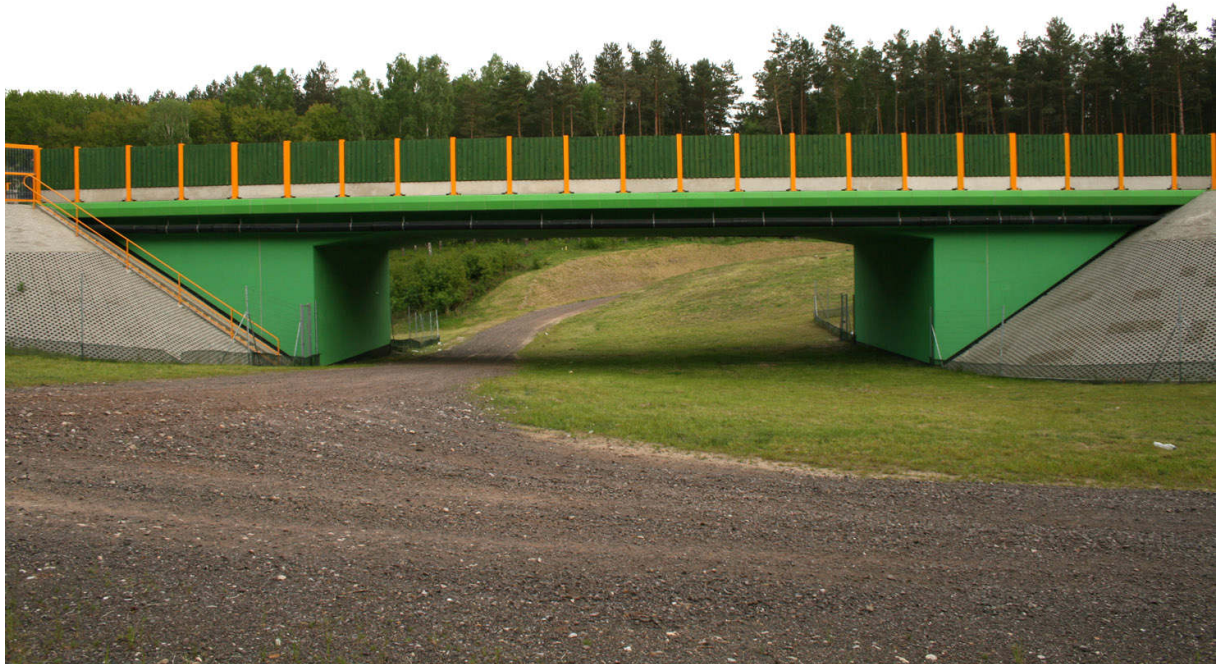
Fot. 2. Przejście dolne dla dużych zwierząt k. miejscowości Chełmsko – droga serwisowa zajmuje dużą powierzchnię pozbawioną roślinności, jej przebieg w otoczeniu przejścia jest niekorzystny i przecina strefy naprowadzania zwierząt.
