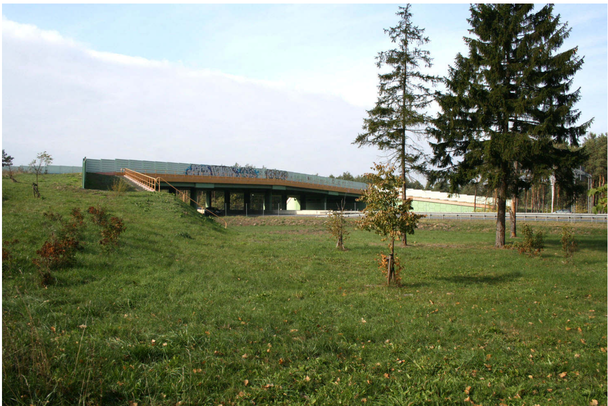
Fot. 2. Górne przejście dla zwierząt w miejscowości Emilianów-ubogie struktury naprowadzające zwierzęta i brak ogrodzenia naprowadzającego
