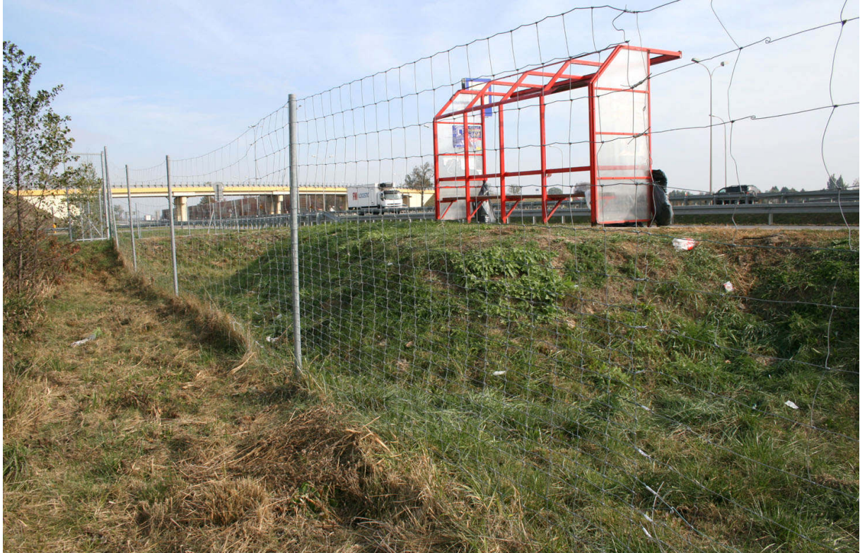
Fot. 27. Lokalizacja przystanków za ogrodzeniem to absurd projektowy, który powoduje, że ogrodzenie nigdy nie będzie szczelne a w bezpośrednim otoczeniu znajduje się cenne siedlisko ssaków kopytnych, w tym łośia
