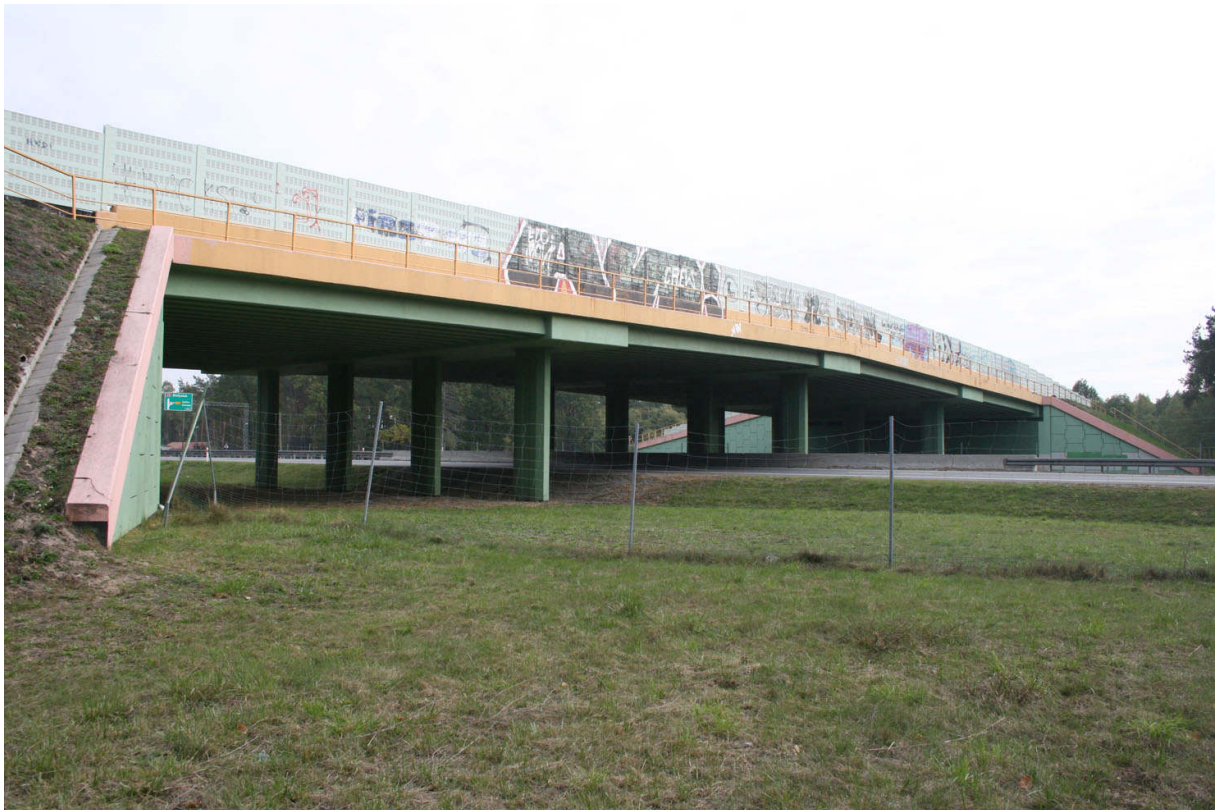
Fot. 16. Górne przejście dla zwierząt w m. Emilianów-pasy dla obsługi ułatwiają graffitiarzom dewastowanie ekranów
