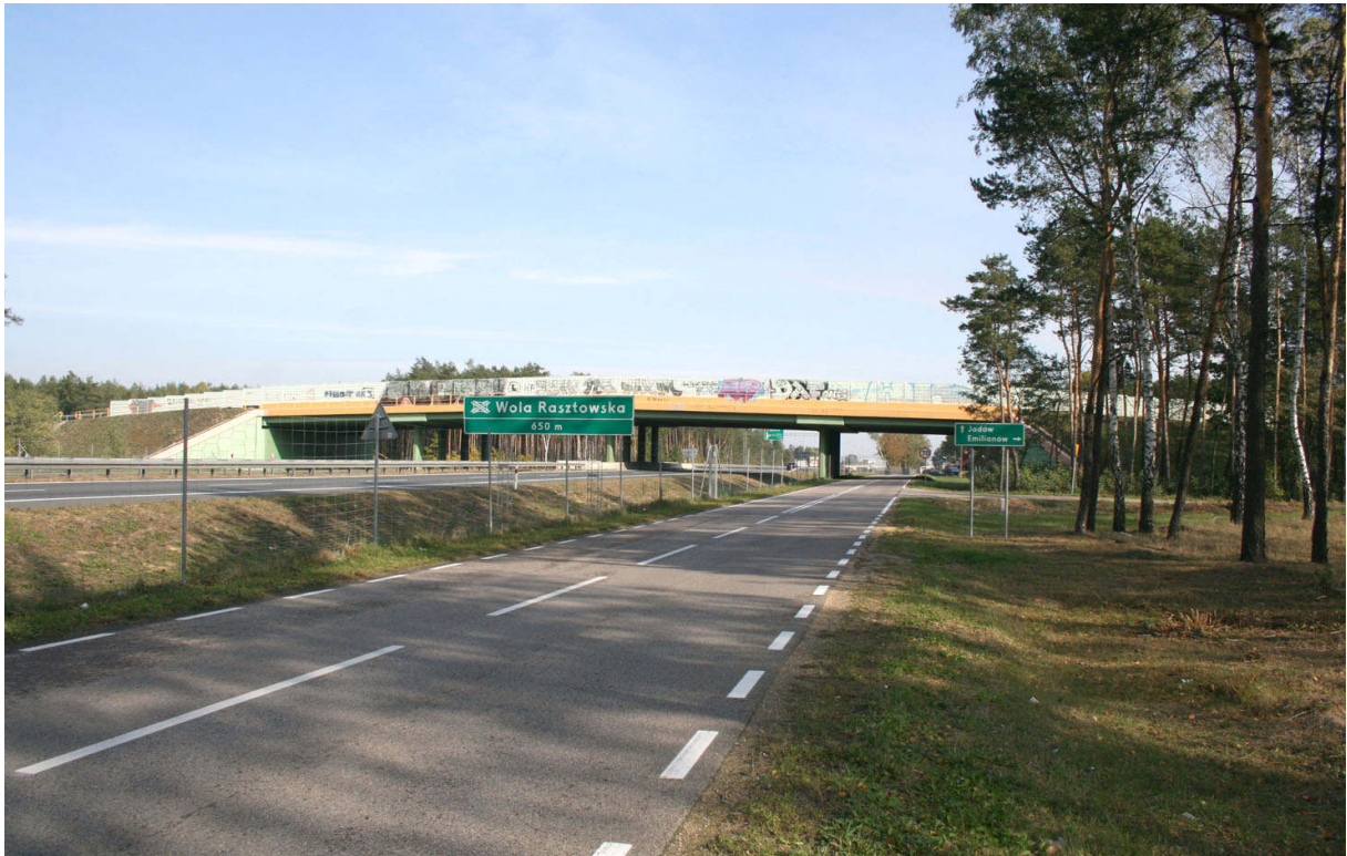
Fot. 1. Górne przejście dla zwierząt w miejscowości Emilianów-jedyny obiekt służący zachowaniu łączności ekologicznej przy analizowanym odcinku drogi S-8
