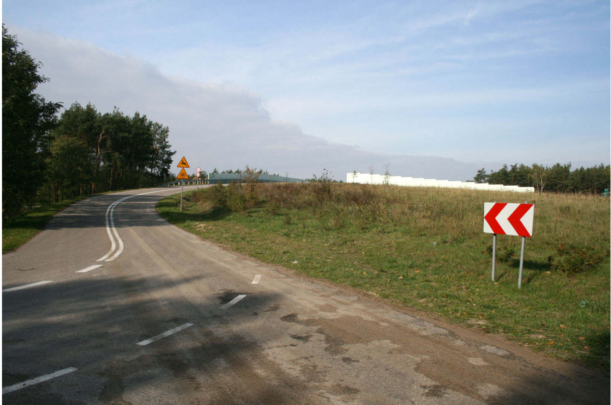
Fot. 11. Górne przejście dla zwierząt w m. Emilianów-asfaltowa droga publiczna na powierzchni to błąd projektowy i istotne ograniczenie funkcjonalności przejścia
