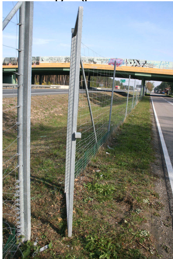
Fot. 18. Otwarta i niezabezpieczona furtka w bezpośrednim otoczeniu górnego przejścia dla zwierząt w m. Emilianów, w obszarze aktywności łośa
