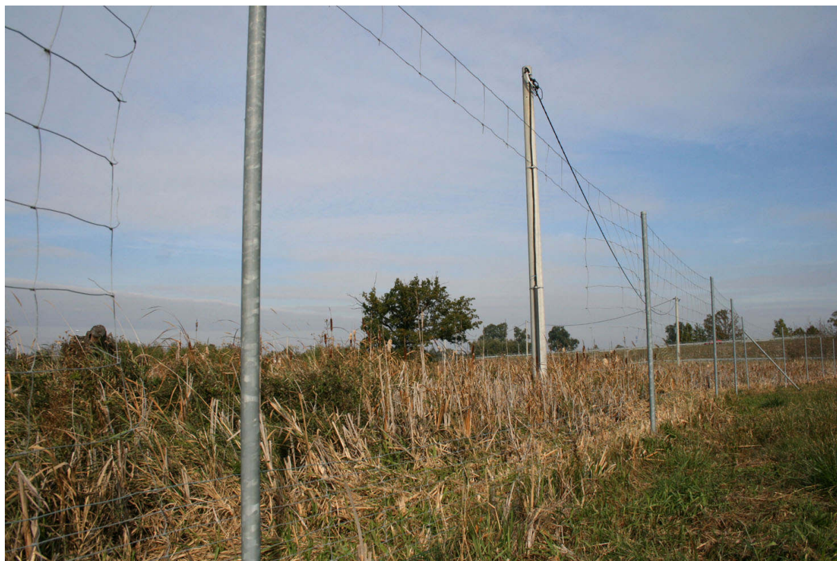
Fot. 24. Uszkodzone ogrodzenie w otoczeniu Węzła Emilianów – w obszarze aktywności łośia
