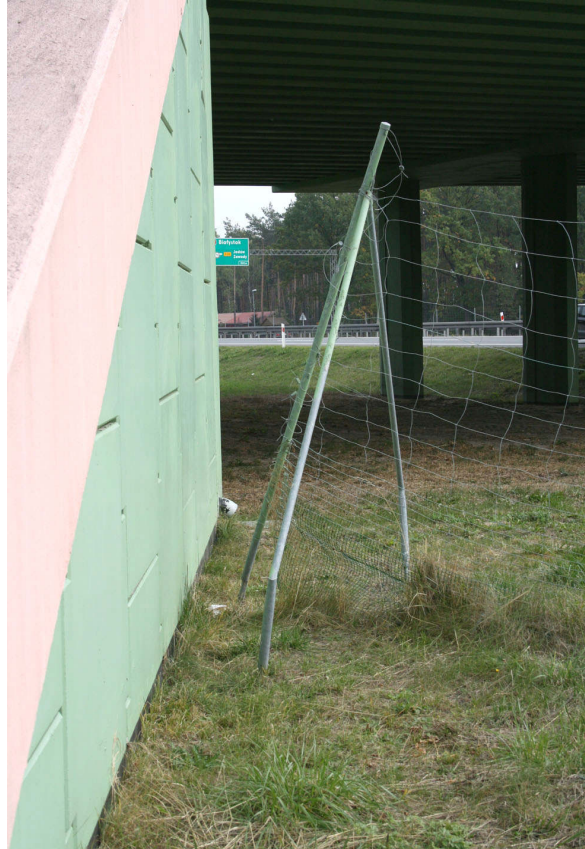
Fot. 17. Górne przejście dla zwierząt w m. Emilianów-nieszczelność w ogrodzeniu wykorzystywana przez ssaki kopytne (potwierdzono w trakcie wizji terenowej)
