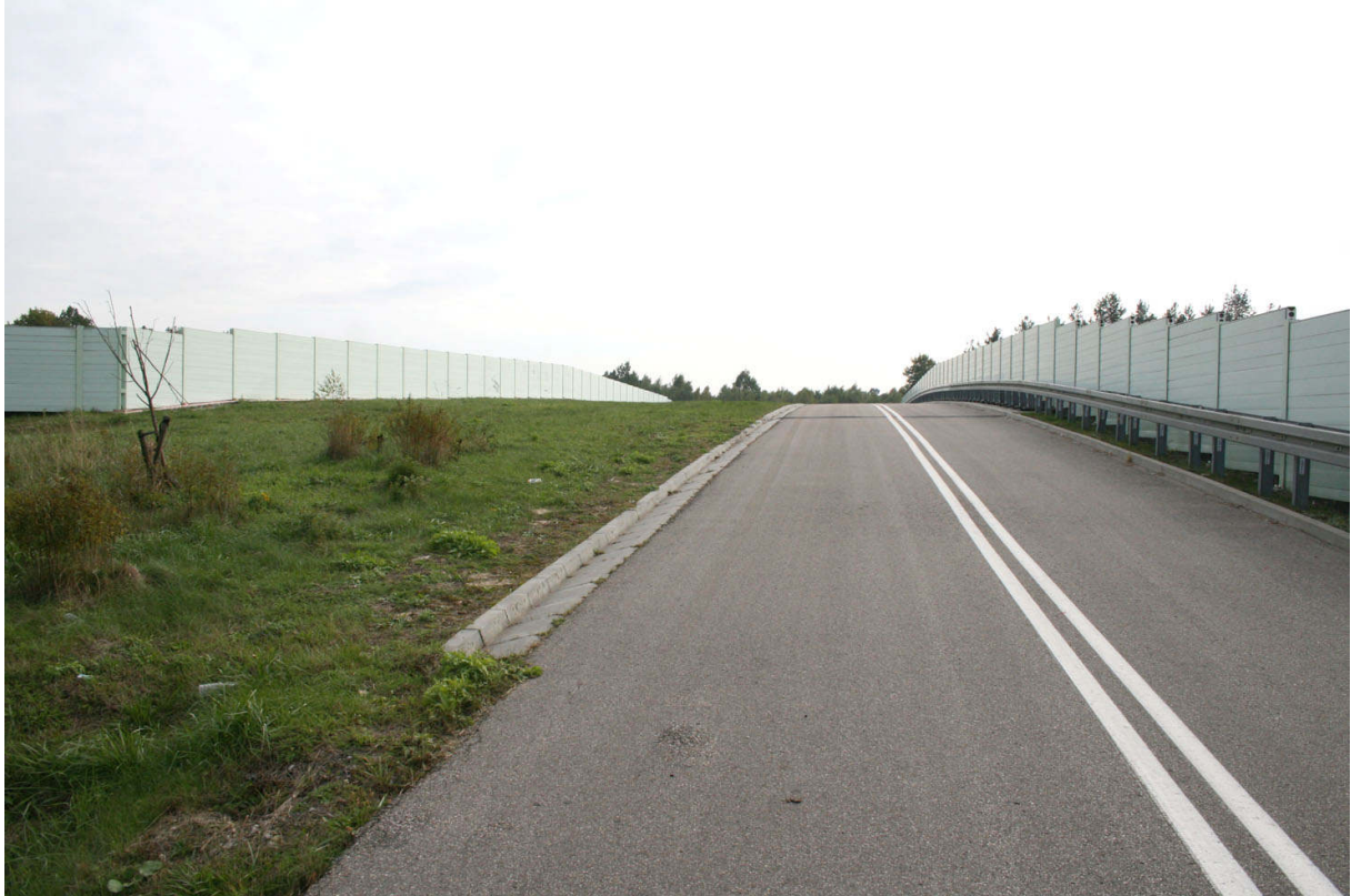
Fot. 13. Górne przejście dla zwierząt w m. Emilianów-asfaltowa droga na powierzchni ogranicza efektywną szerokość przejścia o 30%
