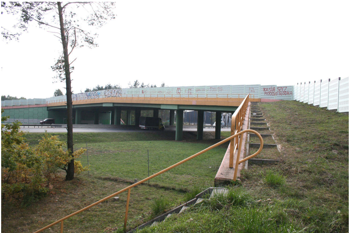
Fot. 4. Górne przejście dla zwierząt w miejscowości Emilianów-od strony północnej pozostawiono szeroki pas dla obsługi, który ogranicza funkcjonalną szerokość przejścia
