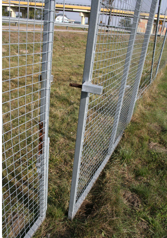
Fot. 21. Otwarta i niezabezpieczona furтка w otoczeniu Węzła Emilianów – w obszarze aktywności łośia
