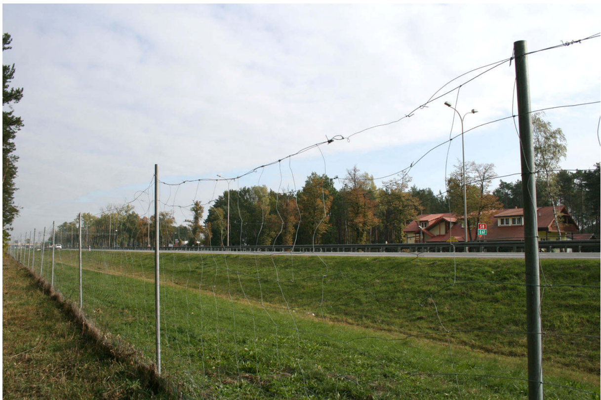
Fot. 20. Typowe, prowizoryczne naprawy uszkodzeń w ogrodzeniach nie pozwalają na zachowanie odpowiedniego naciągu siatki, co ogranicza efektywną wysokość
