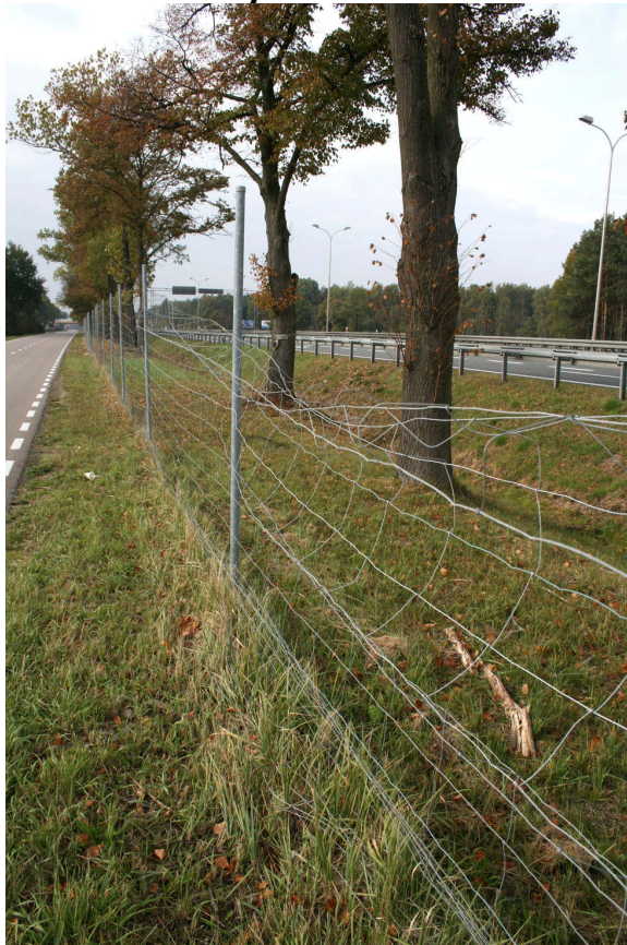
Fot. 22. Uszkodzone ogrodzenie w otoczeniu Węzła Emilianów – w obszarze aktywności łośia
