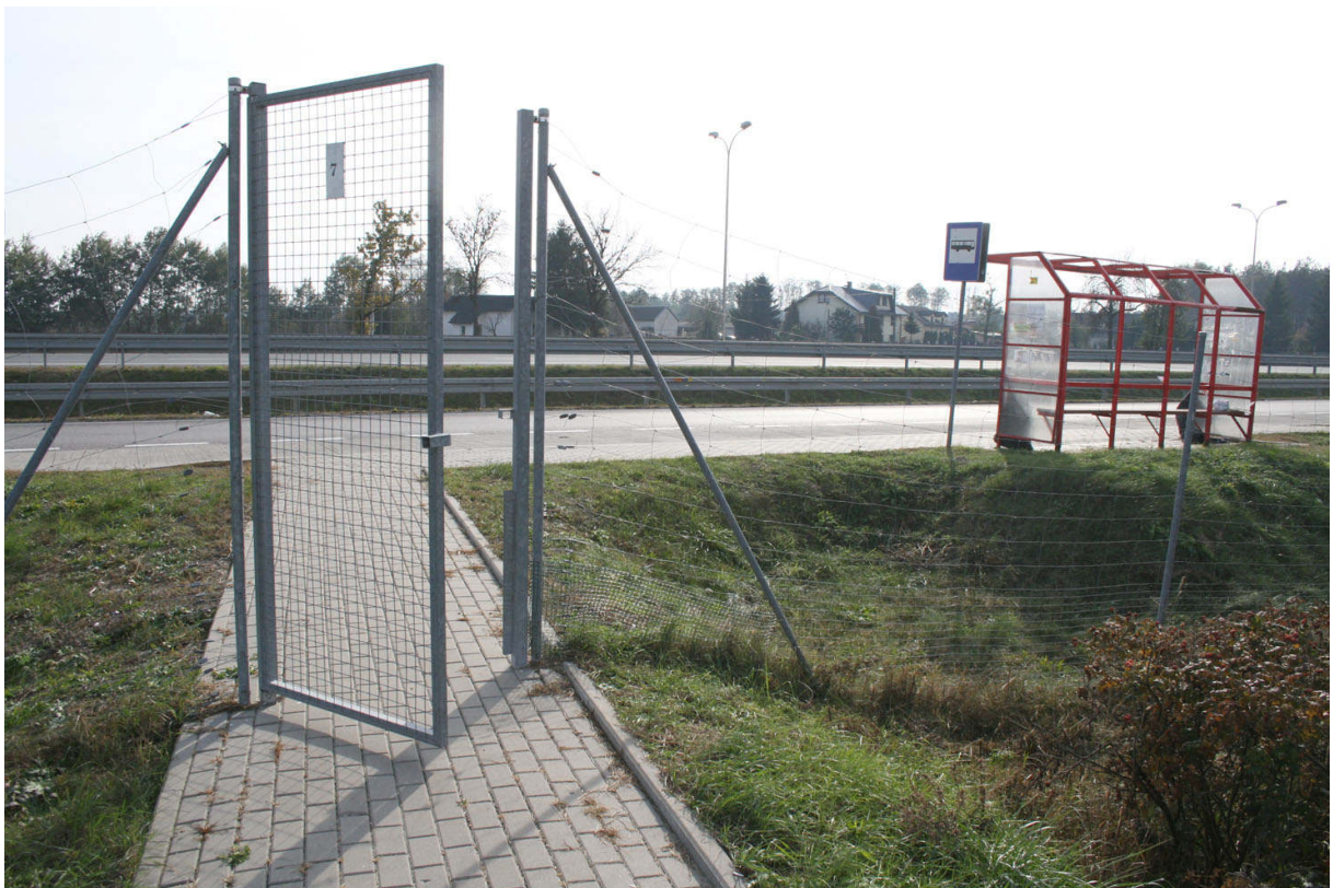
Fot. 26. Furtka w ogrodzeniu prowadząca na przystanek autobusowy-absurd projektowy- wielokrotne otwieranie powoduje istotne zagrożenie bezpieczeństwa ruchu
