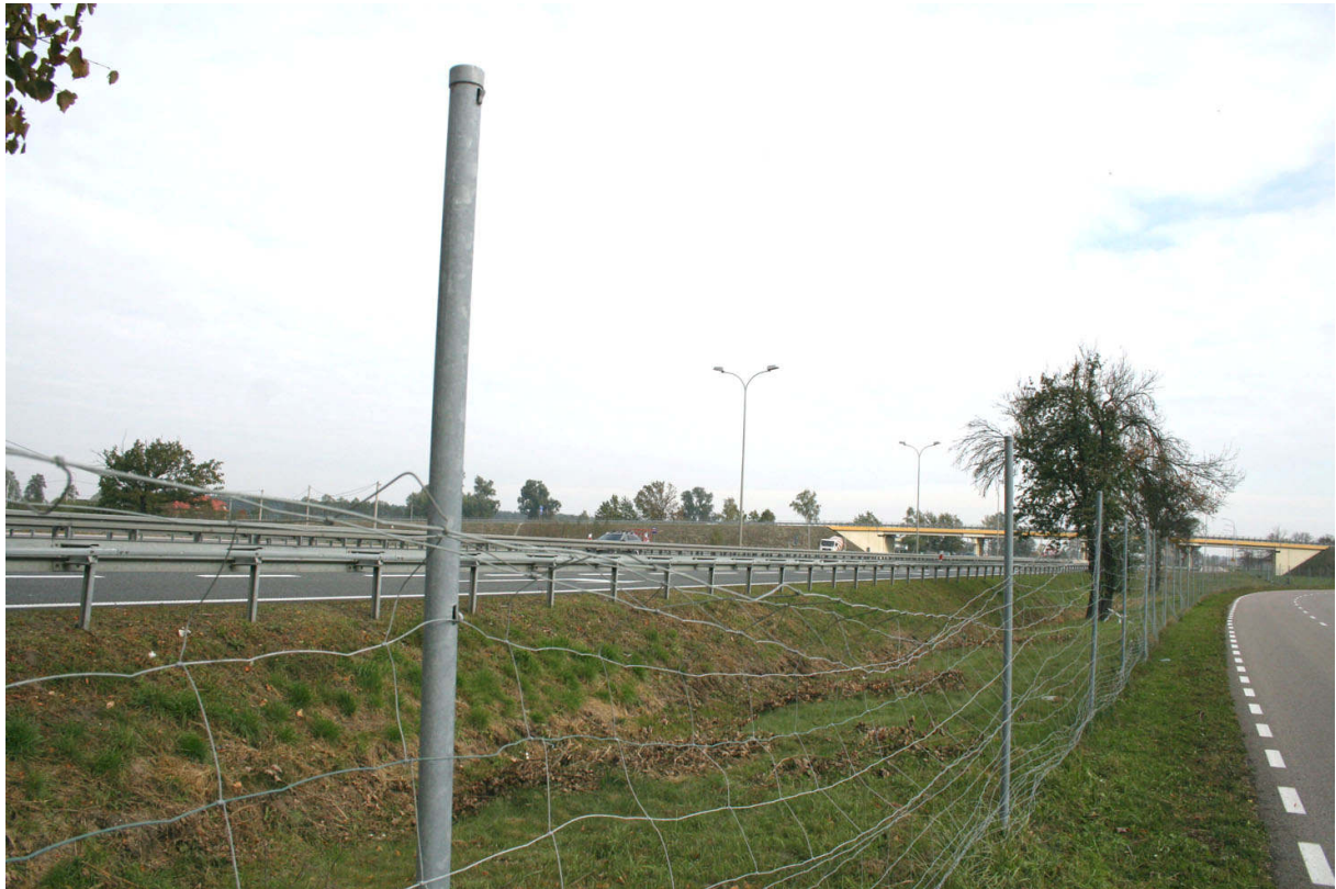
Fot. 19. Zniszczone ogrodzenie w otoczeniu Węzła Emilianów – w obszarze aktywności łosia
