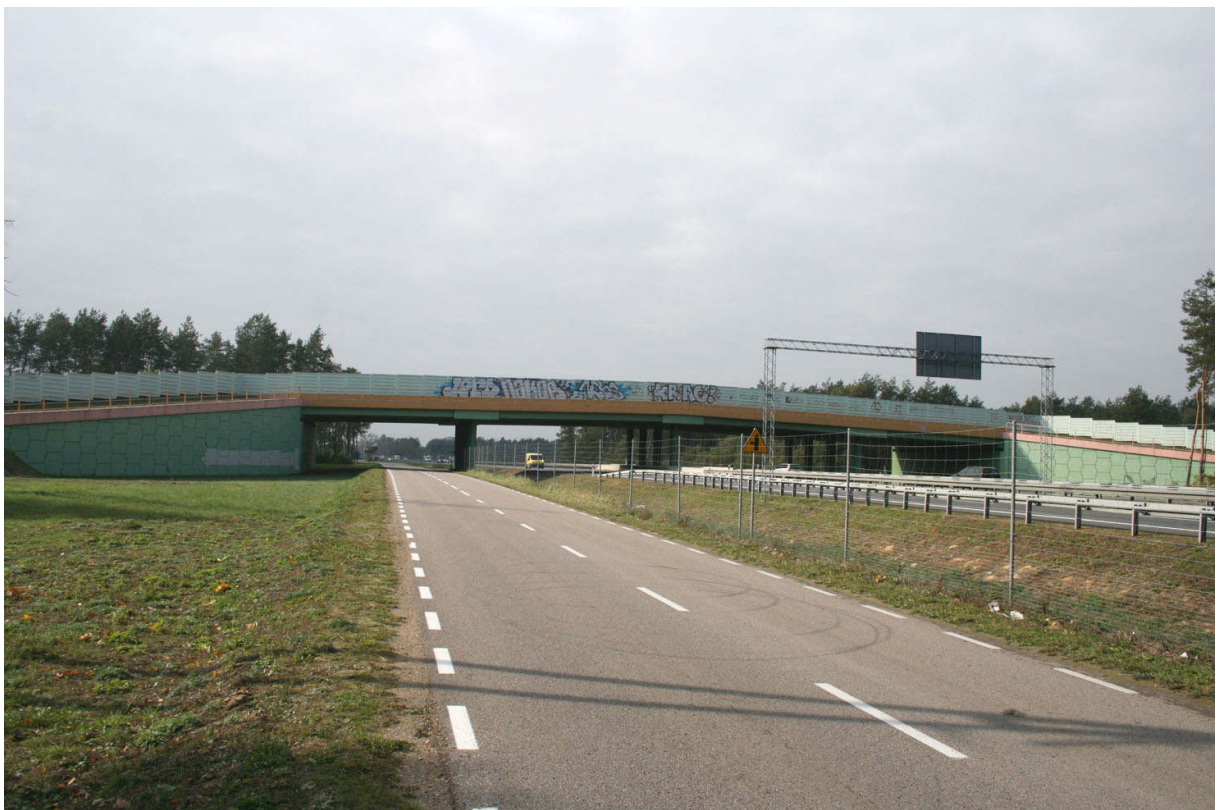
Fot. 10. Górne przejście dla zwierząt w m. Emilianów obejmuje również równoległą drogę lokalną (str. wschodnia), niestety ogrodzenie nie zostało właściwie zlokalizowane
