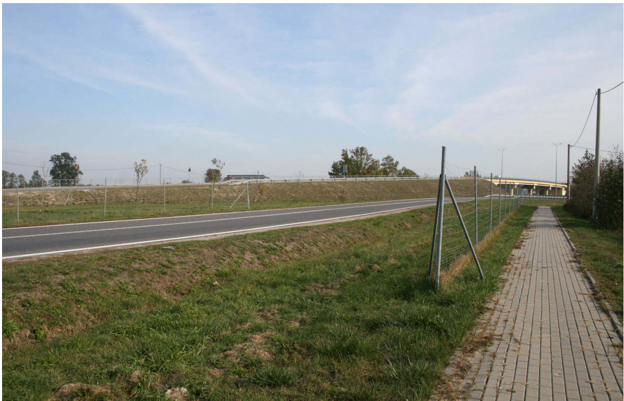
Fot. 28. Ogrodzenie wokół Węzła Emilianów nie jest w pełni skuteczne—odcinki są zbyt krótkie i nie zawsze prawidłowo zlokalizowane – powoduje to istotne zagrożenie dla bezpieczeństwa ruchu, gdyż w otoczeniu znajduje się cenne siedlisko dużych ssaków, w tym łośia
