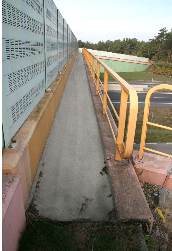
Fot. 7. Górne przejście dla zwierząt w miejscowości Emilianów-pas dla obsługi na wiadukcie zmniejsza swoją szerokość do rozsądnych wymiarów
