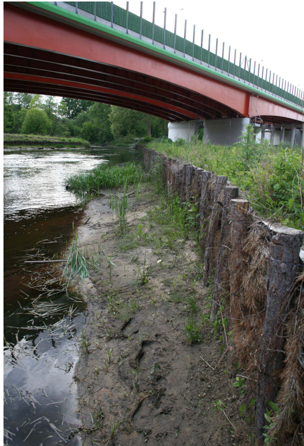
Fot. 18. Przejście dla dużych zwierząt pod mostem nad Obrą-wysoki płotek faszynowy to znacząca bariera dla małych i średnich zwierząt, utrudniająca dostęp do nurtu rzeki
