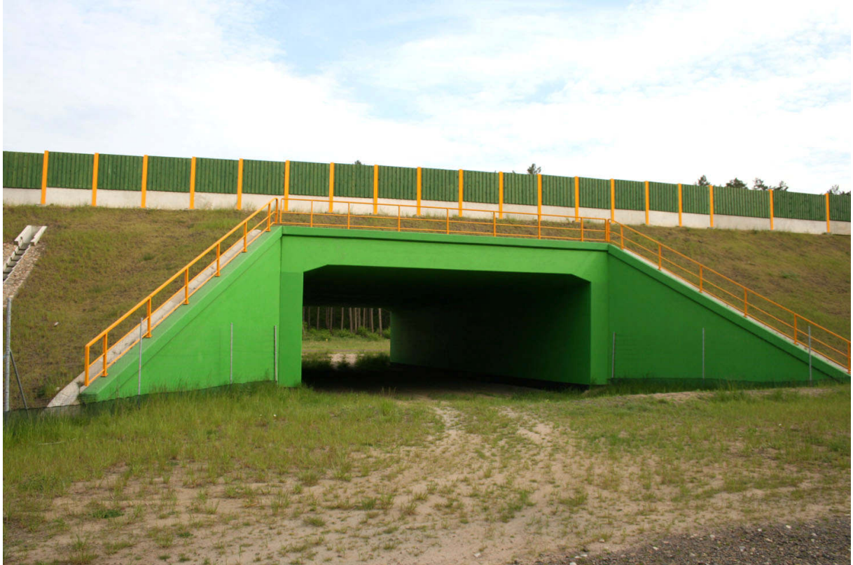
Fot. 22. Przejście dla średnich zwierząt k. Skwierzyny posiada odpowiednią lokalizację i wymiary ale jaskrawe barwy będą odstraszać niektóre gatunki
