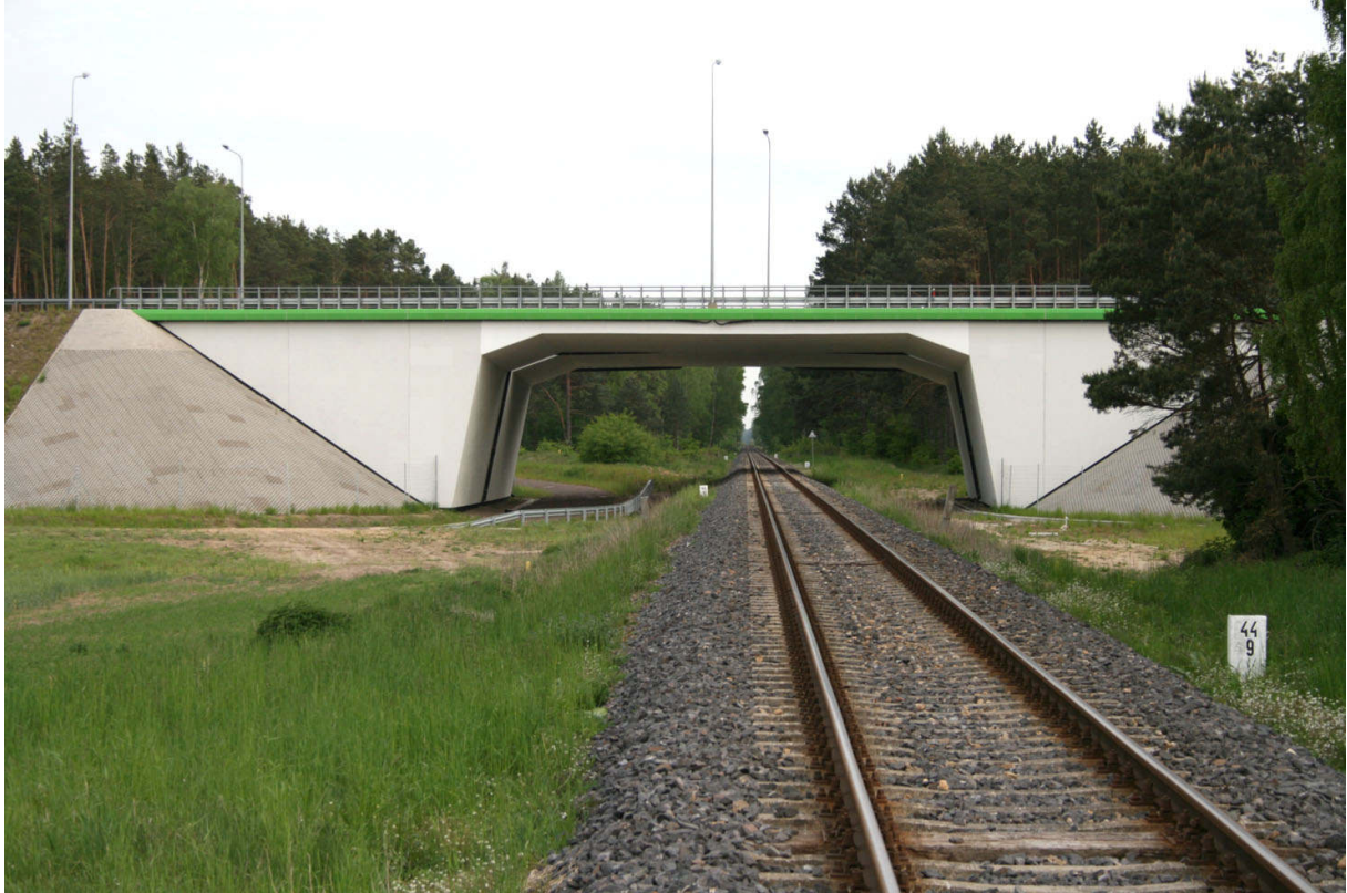
Fot. 26. Przejście dla średnich zwierząt zespolone z linią kolejową- obiekt posiada duże wymiary ale funkcjonalność ogranicza lokalizacja przy oświetlonym odcinku drogi
