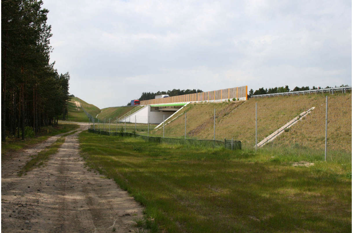
Fot. 10. Przejście dla dużych zwierząt k. miejscowości Rakowo-odcinkowe ogrodzenie naprowadzające i ekran antyolśnieniowy to wymagane wyposażenie każdego dużego przejścia
