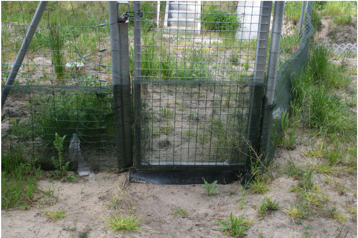
Fot. 32. Nieszczelności przy furtkach powodują ograniczenie skuteczności zastosowanych ogrodzeń z siatek polimerowych
