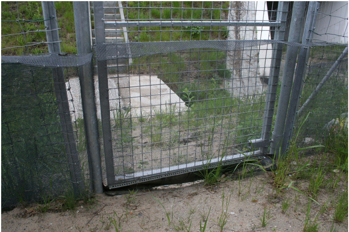
Fot. 31. Nieszczelności przy furtkach powodują ograniczenie skuteczności zastosowanych ogrodzeń z siatek polimerowych
