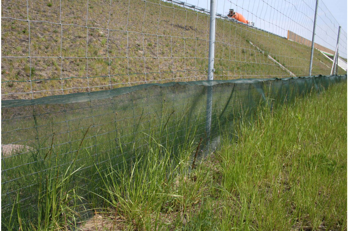
Fot. 30. Ogradzenia z siatek (dla utrzymania skuteczności) wymagają częstego wykaszania roślinności, co z kolei powoduje mechaniczne uszkodzenia siatki polimerowej
