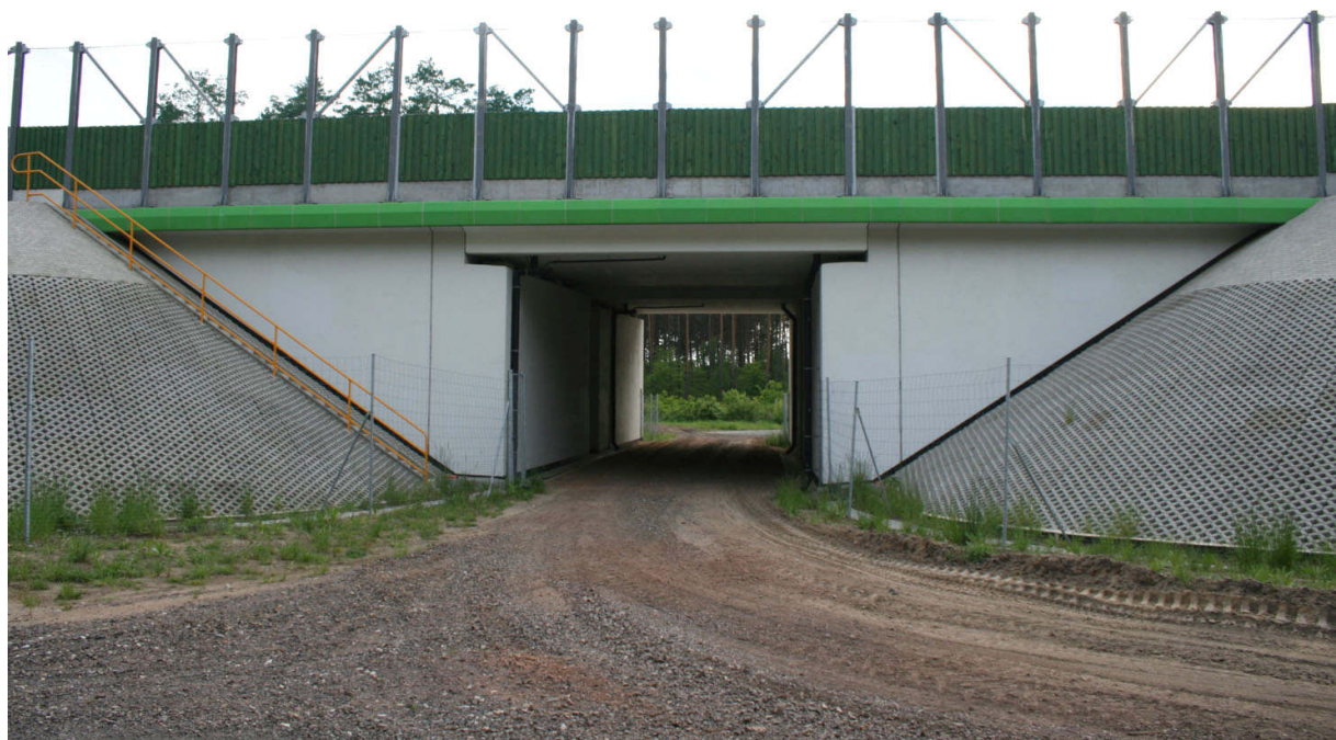
Fot. 19. Przejście dla średnich zwierząt zespolone z drogą wojskową-odpowiednie wymiary i obecność ekranu pozwalają na wykorzystanie przez średnie i małe zwierzęta
