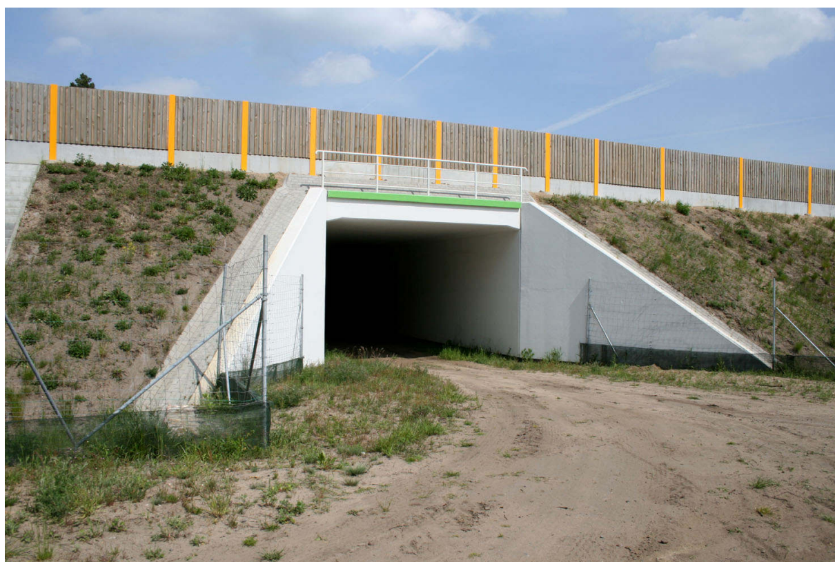
Fot. 3. Przejście dla średnich zwierząt k. miejscowości Trzebieszewo (obiekt I) posiada wystarczające parametry dla kluczowych gatunków i właściwe rozwiązania projektowe
