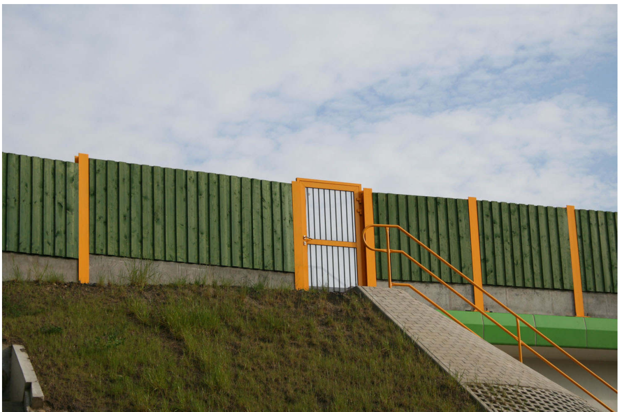
Fot. 21. Przejście dla średnich zwierząt zespolone z drogą wojskową-skuteczny, dobrze zaprojektowany ekran przeciwoślńieniowy, jednak jaskrawa kolorystyka słupów może częściowo odstraszać zwierzęta
