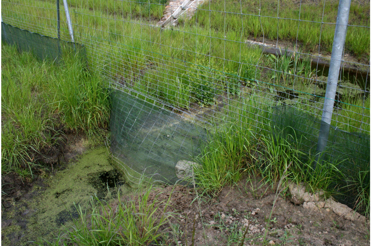
Fot. 34. Nieszczelności w miejscu przekraczania rowów to istotne miejsca przenikania płazów na jezdnie i typowy problem ogrodzeń z siatek polimerowych
