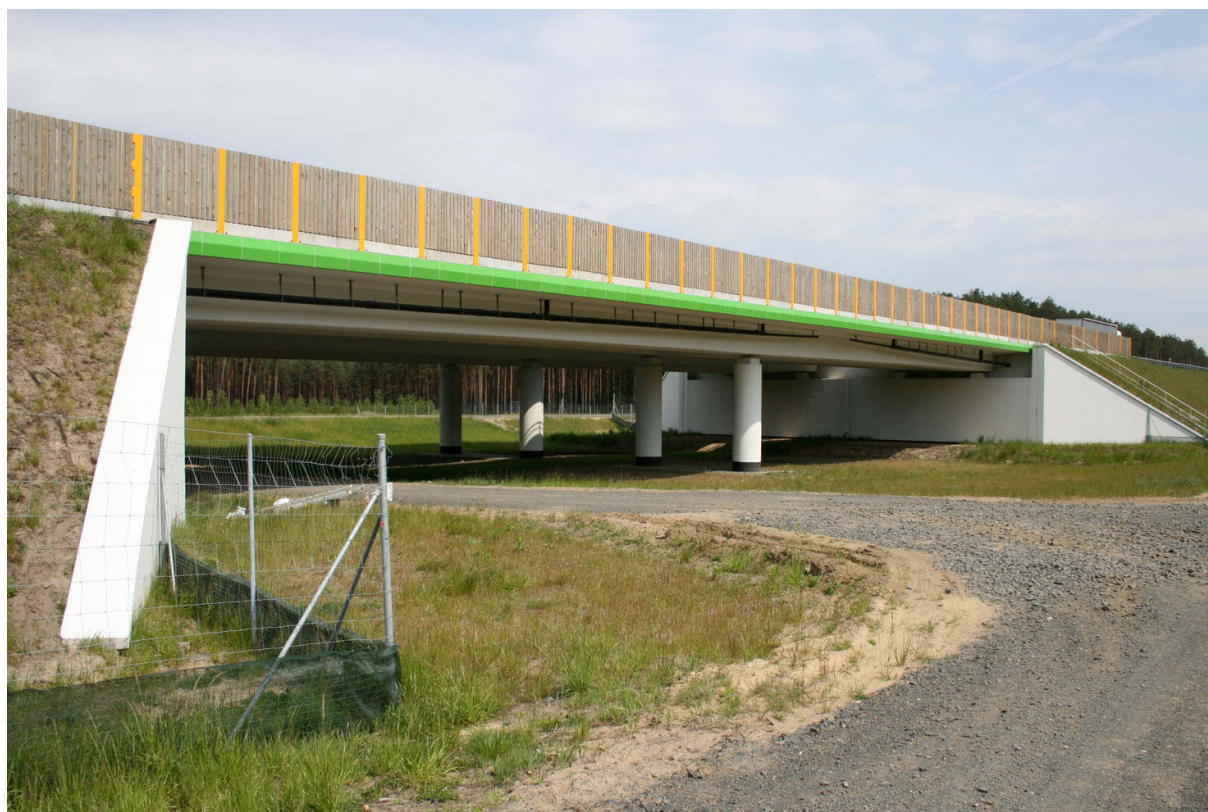
Fot. 1. Przejście dla dużych zwierząt k. miejscowości Brzozowiec posiada optymalne parametry dla ssaków kopytnych i drapieżników
