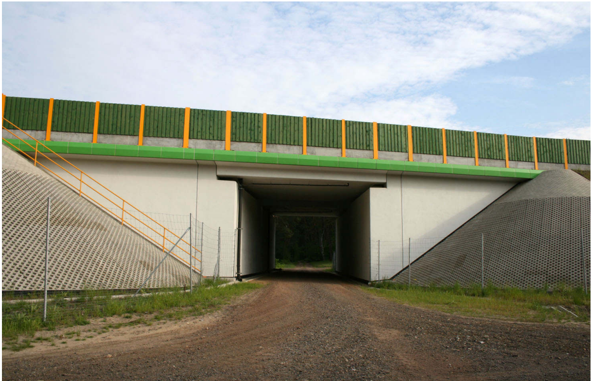
Fot. 20. Przejście dla średnich zwierząt zespolone z drogą wojskową-przykład dobrze zaprojektowanego obiektu zespolonego łączącego skrajne funkcje
