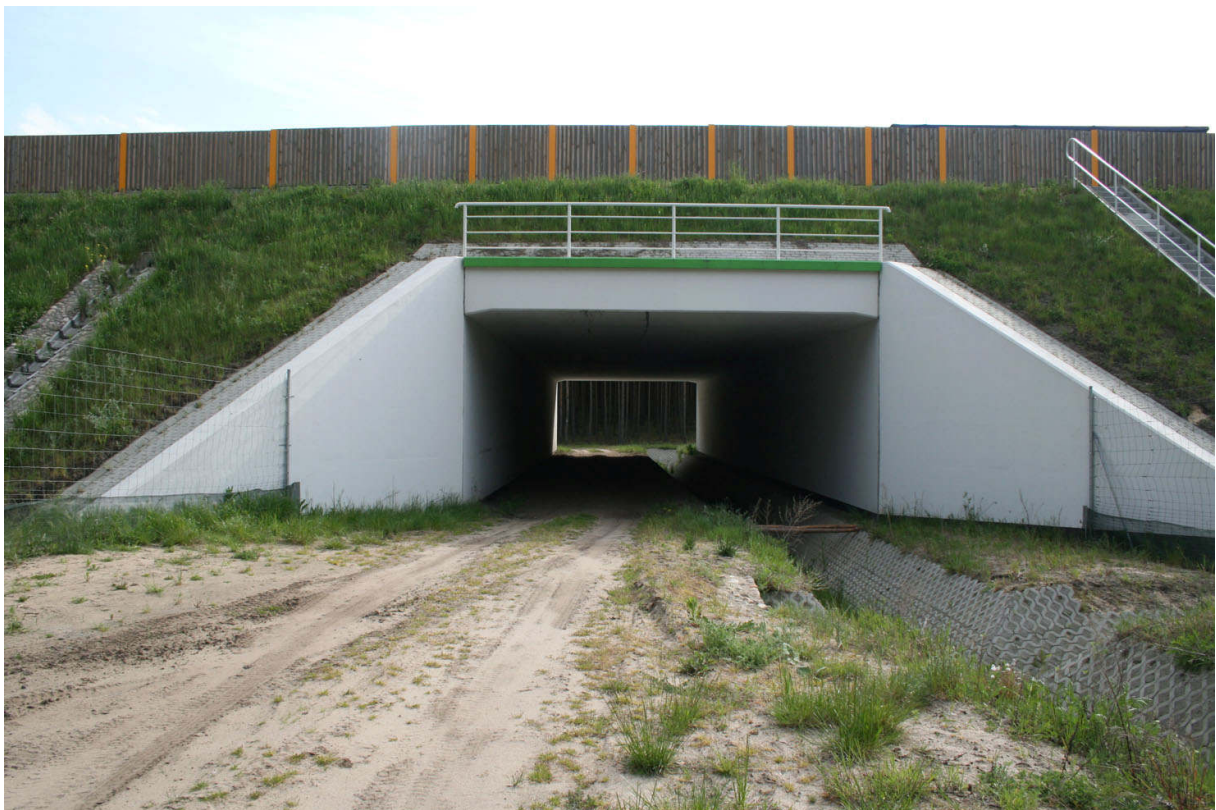
Fot. 11. Przejście dla średnich zwierząt k. miejscowości Rakowo-posiada wystarczające wymiary i właściwe rozwiązania projektowe dla kluczowych gatunków
