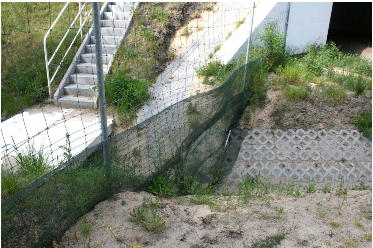
Fot. 33. Nieszczelności w miejscu przekraczania rowów to istotne miejsca przenikania płazów na jezdnie i typowy problem ogrodzeń z siatek polimerowych
