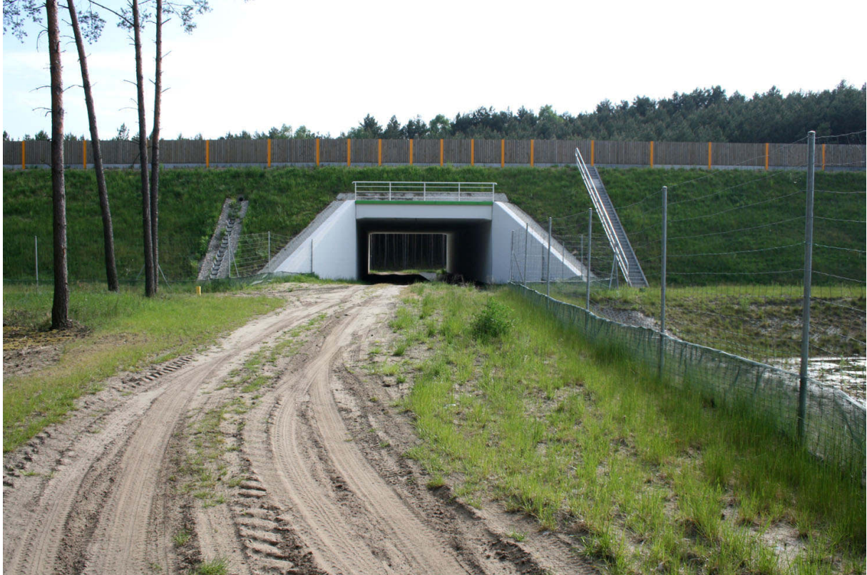
Fot. 14. Przejście dla średnich zwierząt k. miejscowości Rakowo-droga na powierzchni posiada właściwą, gruntową nawierzchnię
