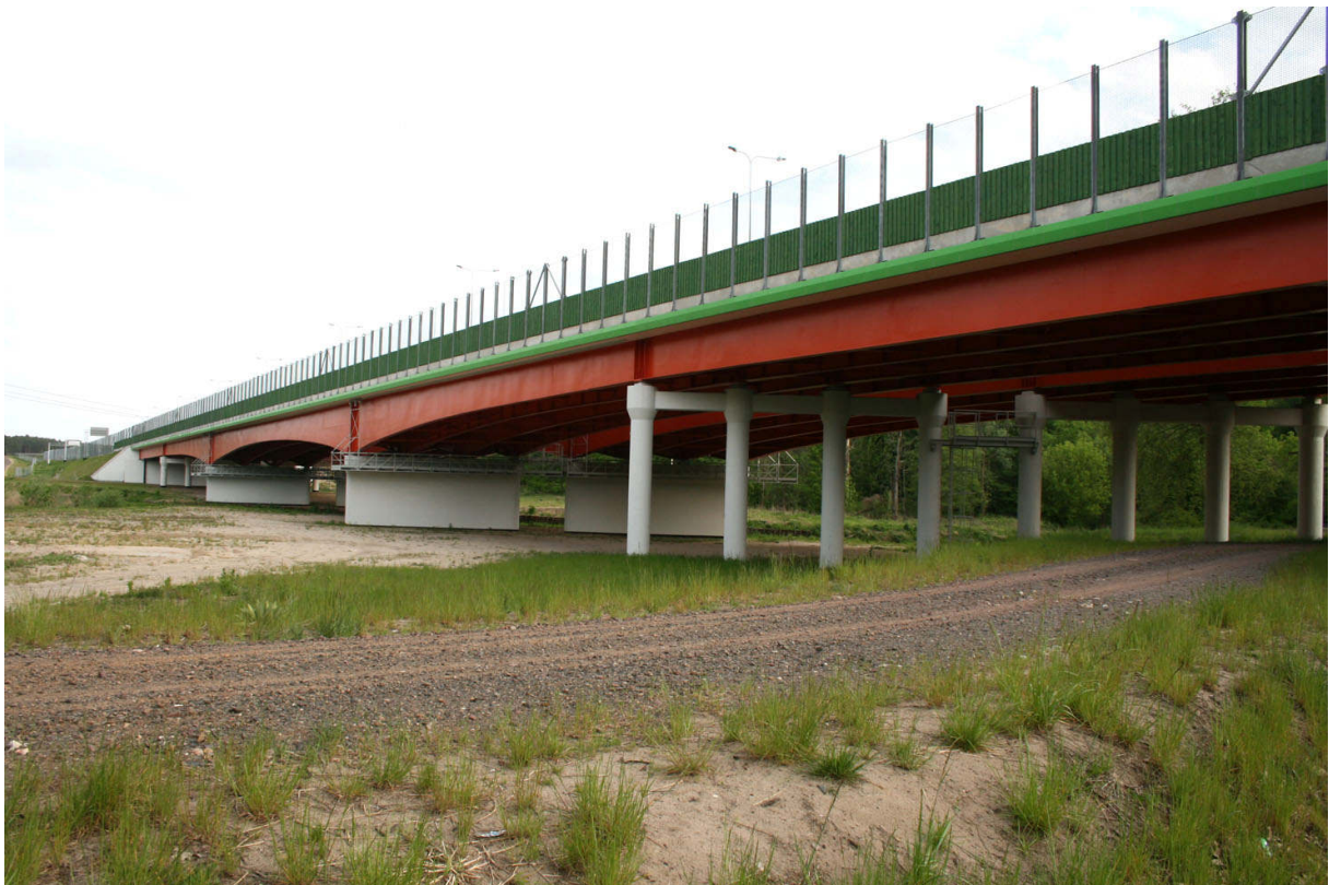
Fot. 15. Przejście dla dużych zwierząt pod mostem nad Obrą-duże wymiary pozwalają na wykorzystanie przez wszystkie gatunki zwierząt, niestety aktywność dużych ssaków ogranicza znacząco lokalizacja na oświetlonym odcinku drogi
