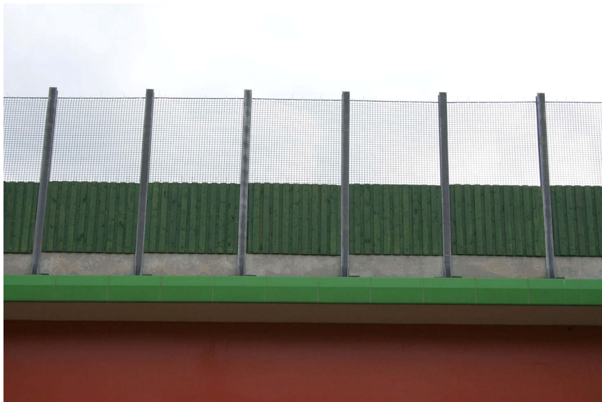
Fot. 16. Przejście dla dużych zwierząt pod mostem nad Obrą-obiekt wyposażony został w ekrany przeciwolśnieniowe i ogrodzenia zapobiegające zbyt niskim przelotom nietoperzy
