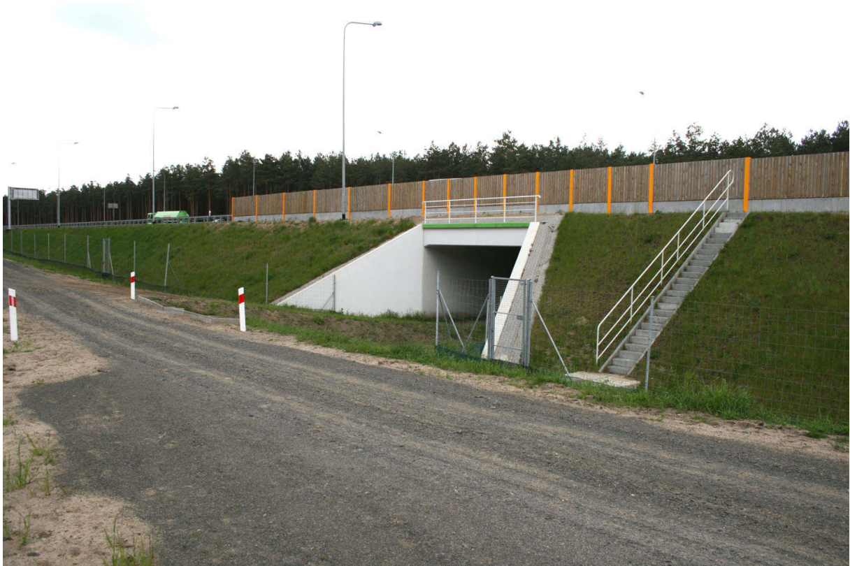
Fot. 6. Przejście dla średnich zwierząt k. miejscowości Trzebieszewo (obiekt II)- lokalizacja na oświetlonym odcinku drogi ogranicza funkcjonalność obiektu dla gatunków leśnych
