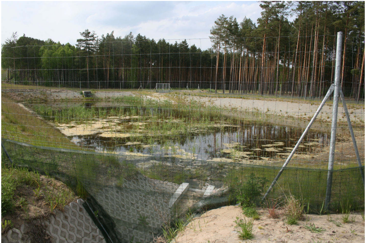
Fot. 28. Niektóre zbiorniki retencyjne zostały ogrodzone przed dostępem płazów (zalecane rozwiązanie) jednak skuteczność zastosowanych ogrodzeń jest niska
