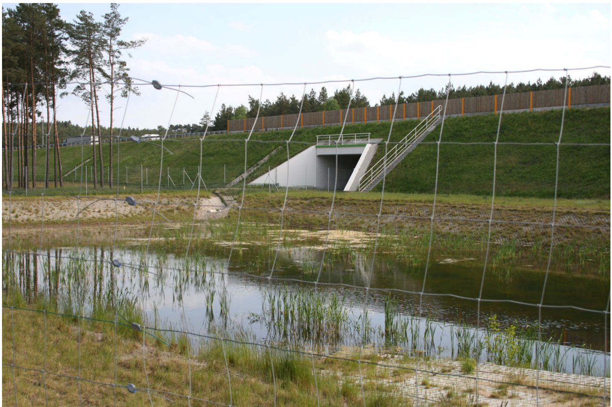
Fot. 13. Przejście dla średnich zwierząt k. miejscowości Rakowo-dostęp do przejścia znacząco utrudnia ogrodzony zbiornik retencyjny
