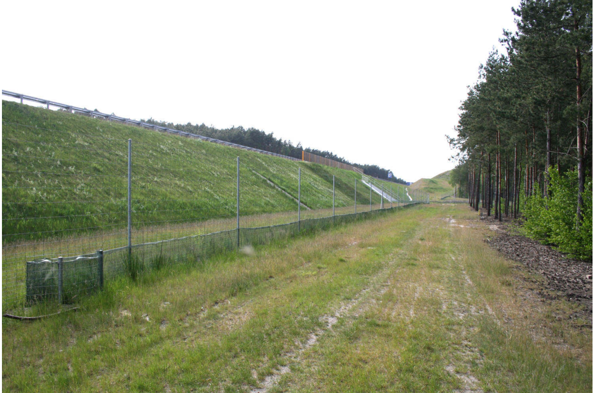
Fot. 12. Przejście dla średnich zwierząt k. miejscowości Rakowo-odcinkowe ogrodzenie naprowadzające zwiększa znaczenie przejścia dla małych ssaków
