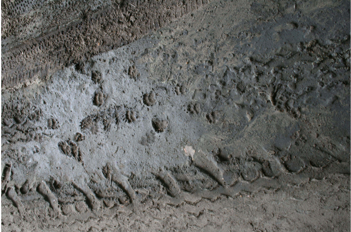
Fot. 4. Przejście dla średnich zwierząt k. miejscowości Trzebieszewo (obiekt I) – liczne tropy borsuka na powierzchni
