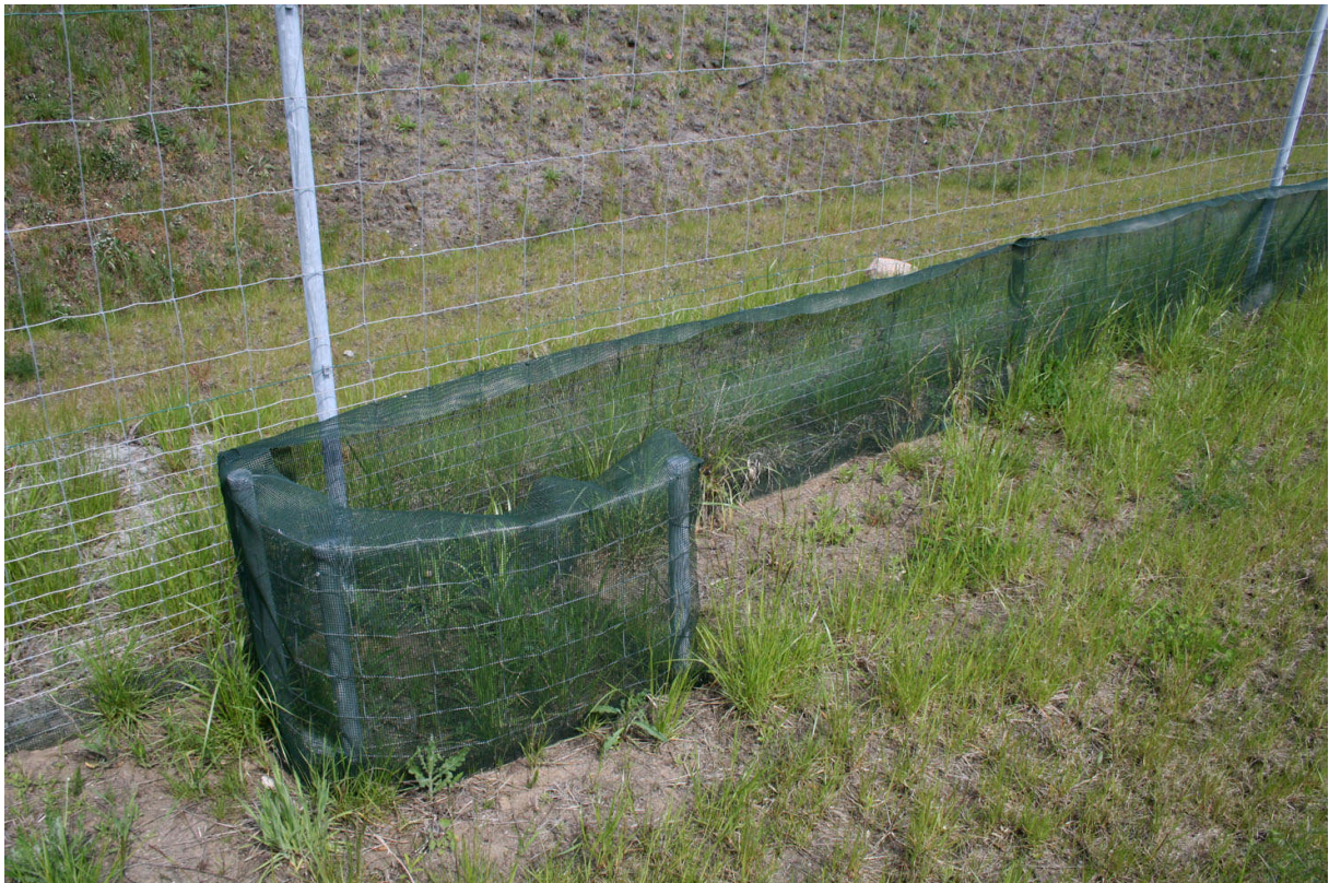
Fot. 29. Ogrodzenia dla małych zwierząt z siatek polimerowych zostały wykonane stosunkowo solidnie ale zastosowany materiał posiada liczne wady ograniczające skuteczność i trwałość konstrukcji
