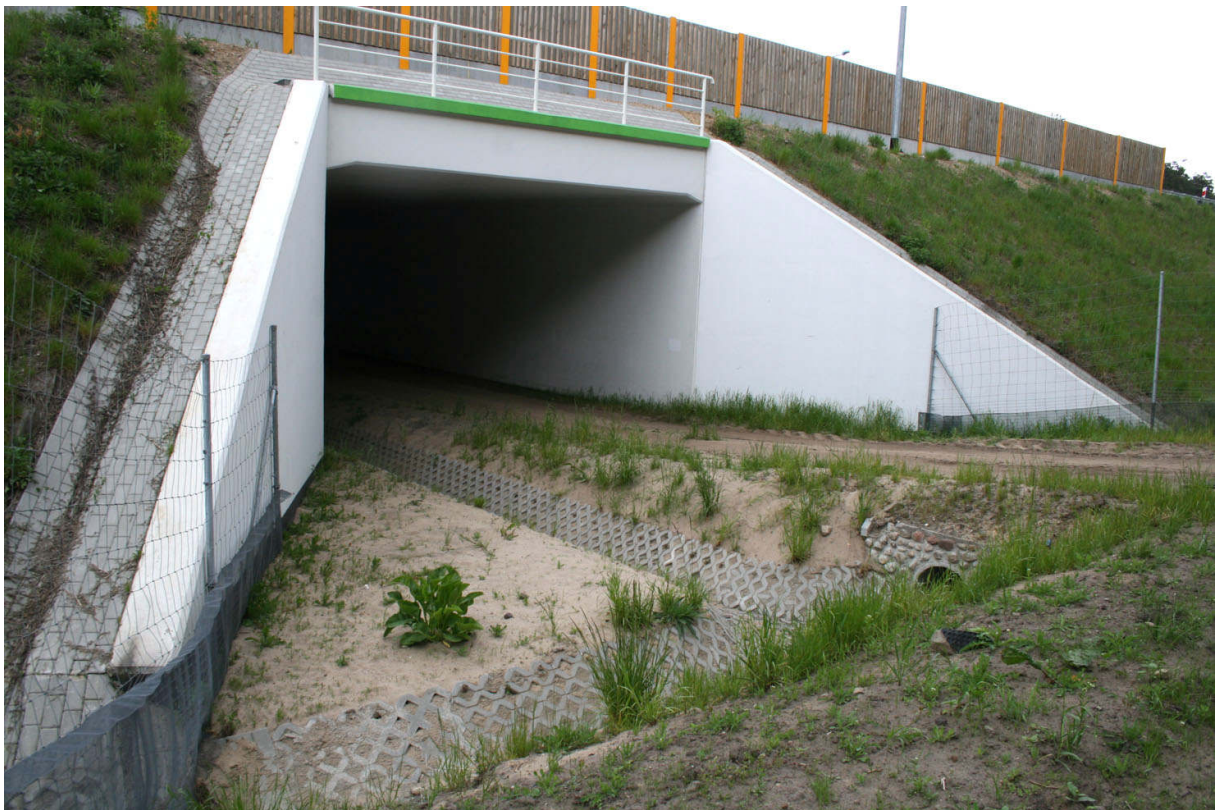
Fot. 5. Przejście dla średnich zwierząt k. miejscowości Trzebieszewo (obiekt II) posiada wystarczające parametry dla kluczowych gatunków ale umocniony rów utrudnia ruch zwierząt
